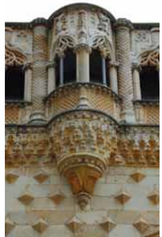
Detalles de la fachada principal.
